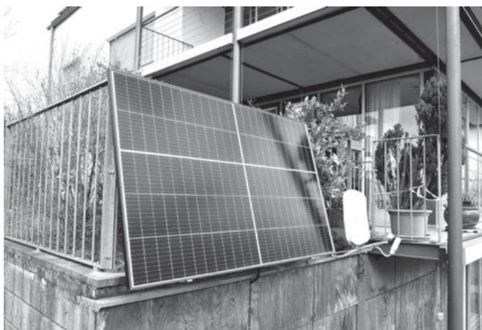
Steckerfertige PV mit einem Modul (Bild BES)
