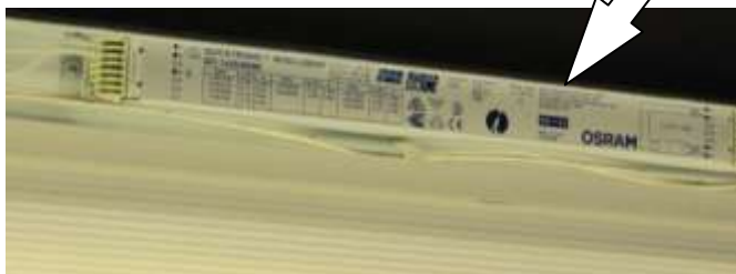
Abb. 8: Geöffnete Siteco-Leuchte (oben) mit EVG der Fa. Osram (Quicktronic Intelligent QT i 1x 35/49/80)
